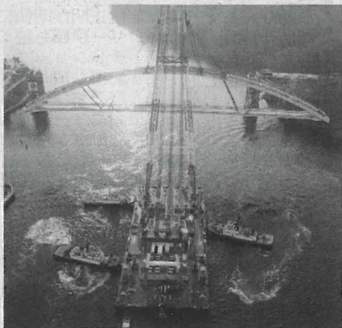
大島大橋の架設作業
